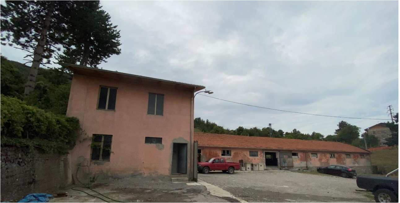
Vista Ex Porcilaia e mangimificio/rimessa
